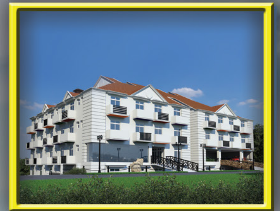
No:10, Kelagala Road, Nuwara eliya.
